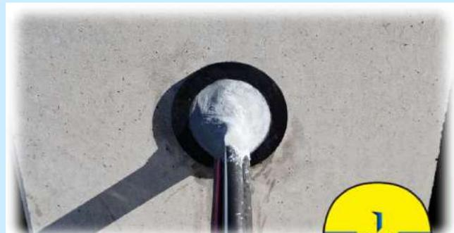
⑧CVTケーブルの場合、仕上げに擦り中央部を指先で念入りに充填し、充填作業完了。
